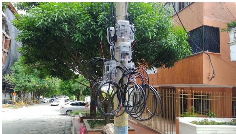
**Figura 2** Instalación de medidores inteligentes fuera de la norma.
